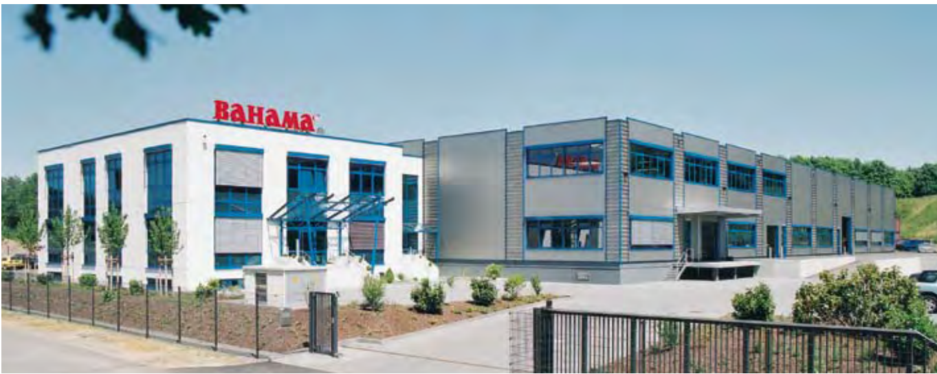
Usine BAHAMA® à D-51580 Reichshof-Wehrath (distr. de Cologne) – Terrain total avec exposition permanente extérieure: 26.000 m².
